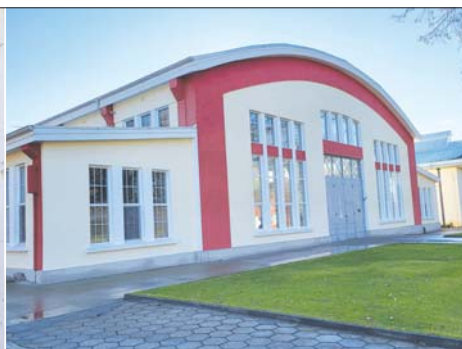
И същата сграда след ремонта
